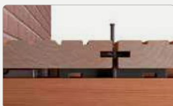
Beginnen Sie mit dem Terrassenwinkel oder StarterClip.
