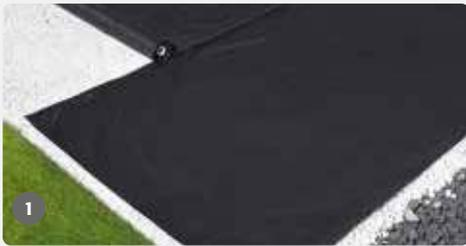
**1** Als ersten Schritt legen Sie eine ebene Fläche an. Anschließend wird eine grobe Schotterschicht (20-40 cm) und eine anschließende Kiesschicht (5 cm) auf der Fläche verdichtet. Bitte beachten Sie, dass die Fläche ein Gefälle von ca. 1-2 % haben muss. Es wird empfohlen, zusätzlich ein Unkrautvlies als Schutz zu verlegen.
