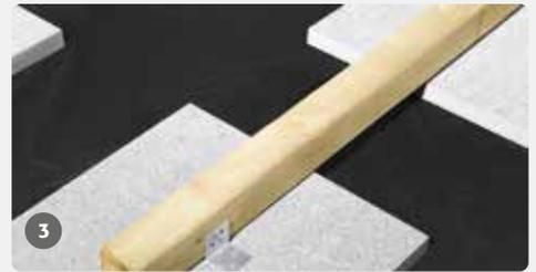
**3** Unterkonstruktion hochkant und mittig auf die Steinplatten legen und an mindestens drei Punkten mit Metallwinkeln befestigen. Je nach Holzart und Stärke der Terrassendiele sollte der Abstand der Unterkonstruktion zwischen 20 und max. 50 cm liegen.
